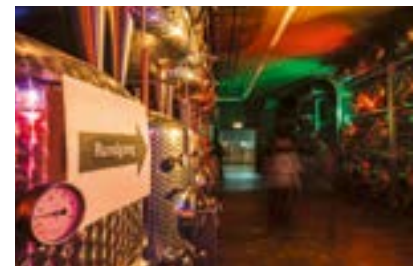
Würzburg, Stahltanks Bürgerspital Weingut © Bürgerspital Weingut Würzburg
